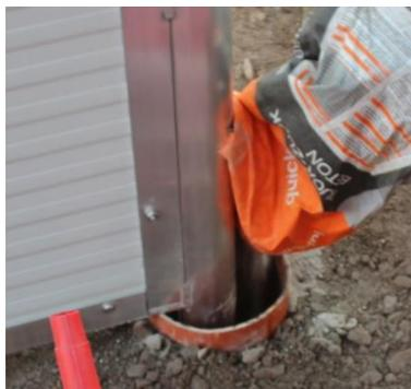
**10.** Die Leerrohre mit Beton C20/25 verfüllen und verdichten. Vor dem Abbinden die Ausrichtung und Fluchten erneut kontrollieren.
