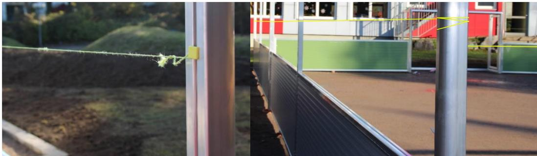
**9.** Anschließend die Ausrichtung und Fluchten mit einer Richtschnur und Wasserwaage korrigieren.
